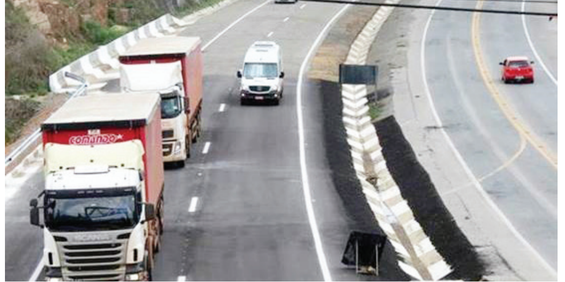
As equipes da Concessionária finalizaram os trabalhos de reforço da sinalização de segurança, limpeza da pista e desvio de tráfego
